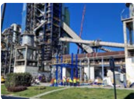
Hier soll die CO 2 -Abscheideanlage gebaut werden.
